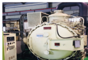
공장 침탄 열처리로 교체 침탄 열처리로 1대 교체
