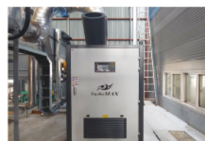
공장 터보블로어 교체 터보블로어 61kW 1대 교체
