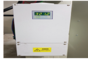
아파트 회생제동장치 설치 회생제동장치 22kW 75대 교체
