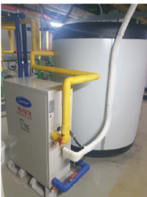
요양원 히트펌프 보일러 교체 히트펌프 보일러 2대(8HP) 설치
