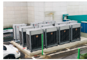
대학교 냉난방설비 교체 EHP 4대(322kW) 설치
