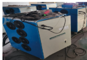
공장 IGBT정류기 교체 IGBT 정류기 1대(60V) 교체
