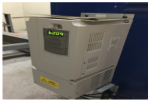
아파트 회생제동장치 설치 회생제동장치 15kW 154대 교체
